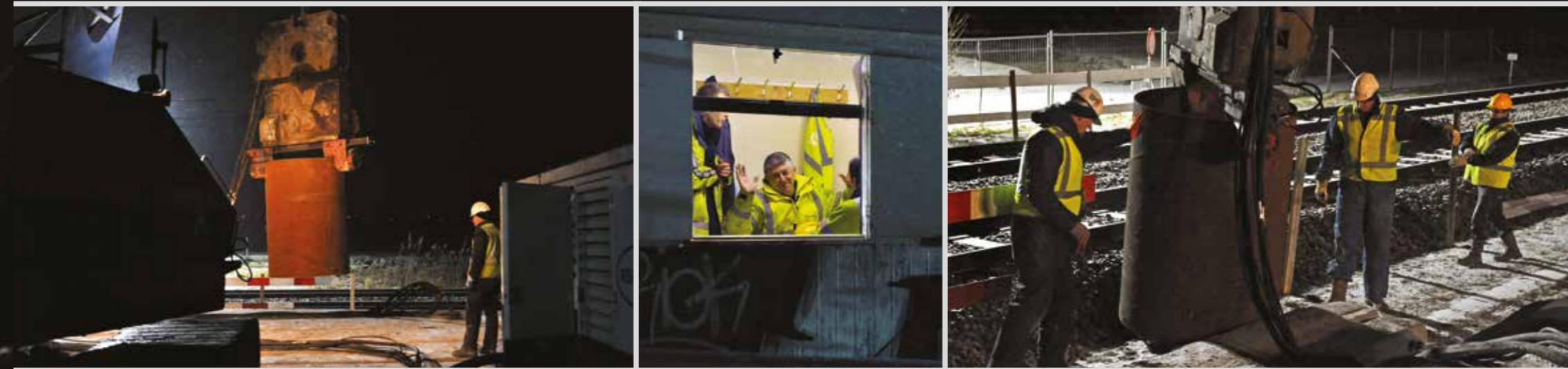
Het fundament langs de trambaan werd 's nachts aangebracht, zodat het openbaar vervoer geen hinder had van het werk.
