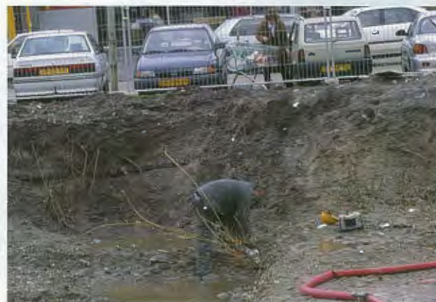
Het begin van de parkeergarage aan het Bogaardplein.
