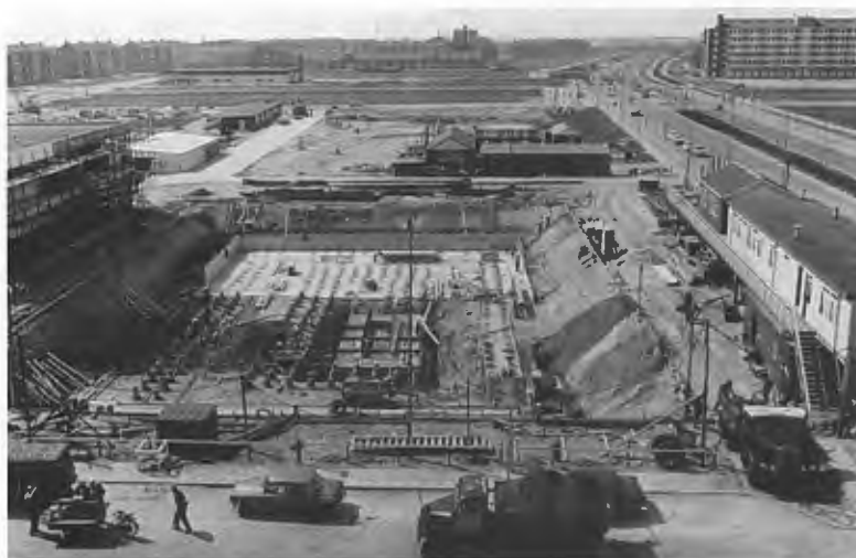
De allereerste bouwwerkzaamheden in een nog niet volgebouwde omgeving.
