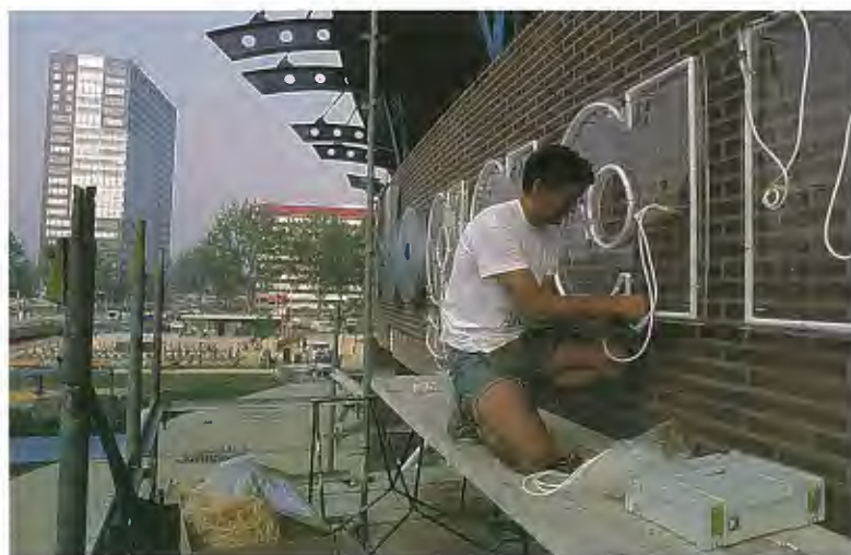
De entree van de Prinsenpassage in aanbouw.
