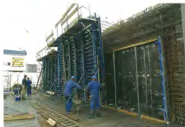
Impressies van de bouw van het Konmarblok.
