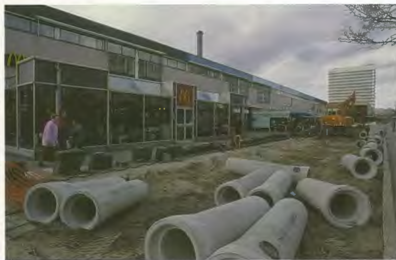
Vorbereidende werkzaamheden aan de kant van de Steenvoordelaan.
