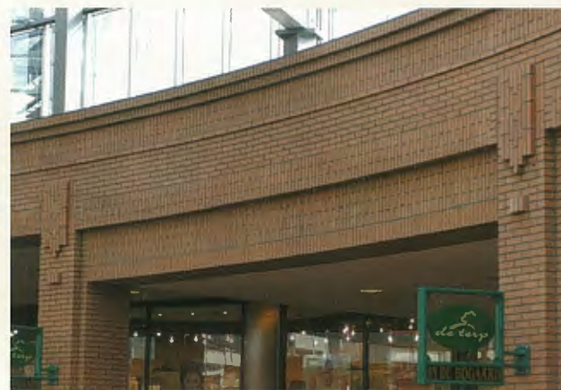
Mooi metselwerk in de Terp.
