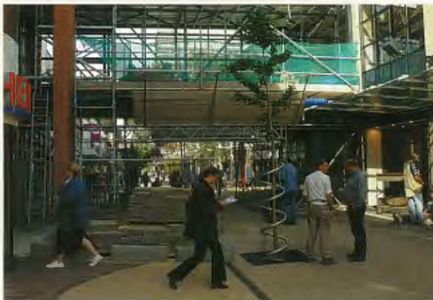
Een voetgangersbrug verbindt de Terp met de Sterpassage.
