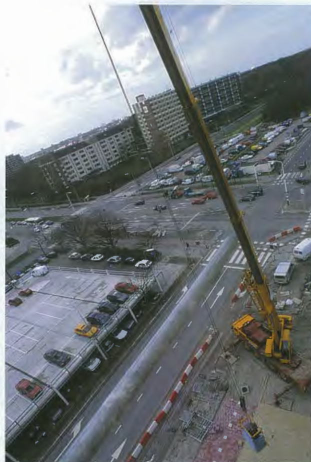
Voor de bouw van de appartementen bij de Terp was een hoogwerker nodig. Links het parkeerdek aan de Prinses Beatrixlaan.
