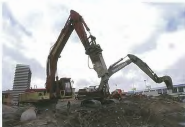
Graafwerkzaamheden voor de parkeergarage onder het Bogaardplein.
