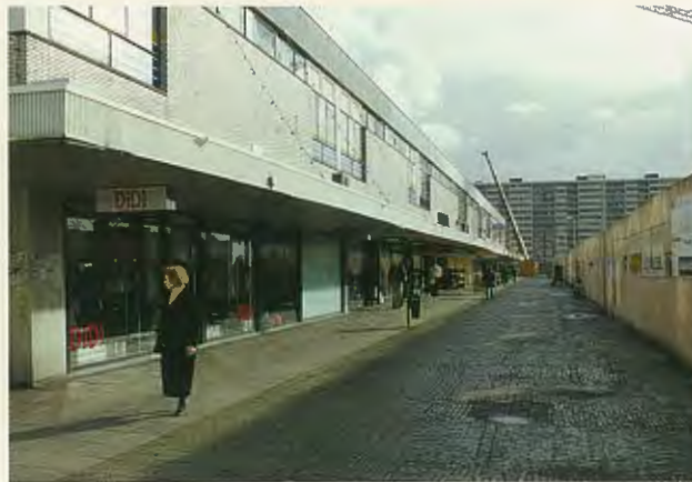
De Prins Constantijnpromenade tijdens de renovatie.
