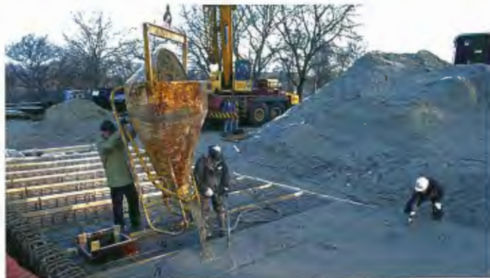
In de vroege, erg koude ochtenduren wordt de laatste hand gelegd aan de nieuwe brug over de Reijnerwetering
