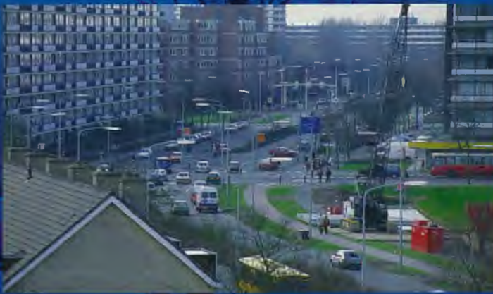
De Sir Winston Churchilllaan in oude staat. De heimachine rechts was nodig voor het heien van het fundament voor de kademuur langs het water
