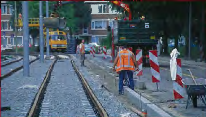
De aanleg van de trambaan op de Burgemeester Elsenlaan net over de gemeentegrens met Den Haag
