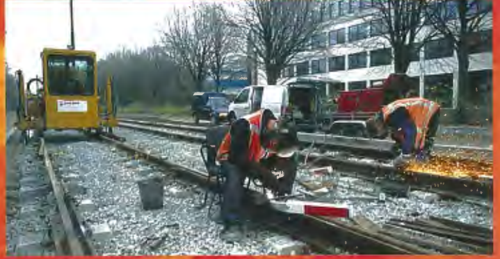
In de Plaspoelpolder worden rails gelast
