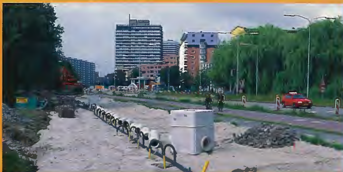
De Sir Winston Churchilllaan tussen de Volmerlaan en het Generaal Eisenhowerplein in afwachting van het werken aan kabels en leidingen
