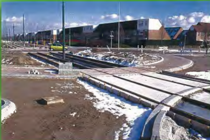
In de kruising Florence Nightingalestraat/Mgr.Bekkerslaan/Eikelenburglaan/Van der Kooijweg is een rotonde aangelegd, waardoor het gemotoriseerde verkeer minder hard kan rijden.
