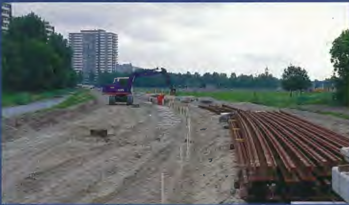
In de Hoekpolder liggen de tramrails klaar. Evenals in Waringse Veld moest de drassige bodem inklinken, zodat die stevig genoeg werd om de trambaan te dragen. Dit gebeurde met behulp van een zogeheten voorbelasting: een grote berg grond
