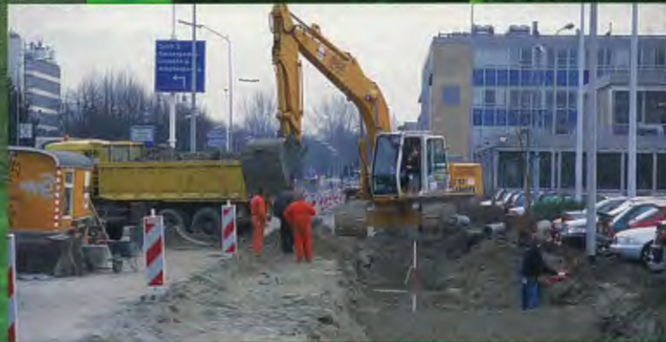
Het graven van het cunet in de Plaspoelpolder
