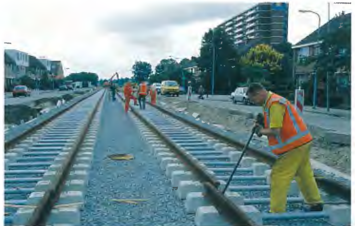
In de Florence Nightingalestraat worden de rails op hun plek gelegd
