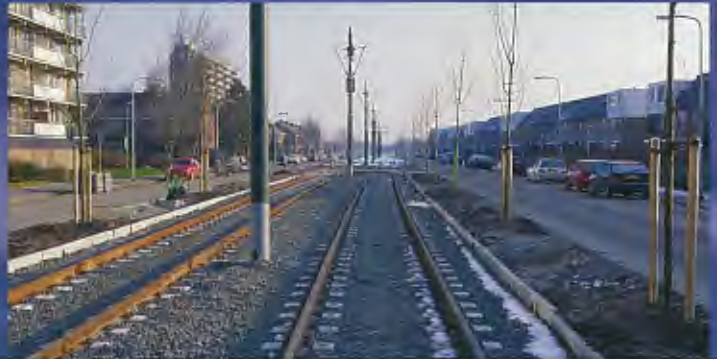
De trambaan is in de Florence Nightingalestraat in de middenberm aangelegd.
