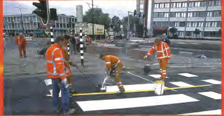
Nadat de weg opnieuw is geasfalteerd, wordt een nieuwe zebra aangebracht
