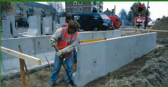
De halte voor het stadhuis van Rijswijk wordt aangelegd.
