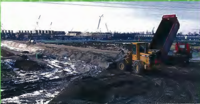
Voorbelastings in Wateringse Veld
